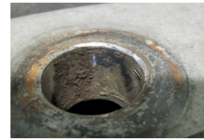
Corrosión galvánica en el área de contacto de la tuerca
