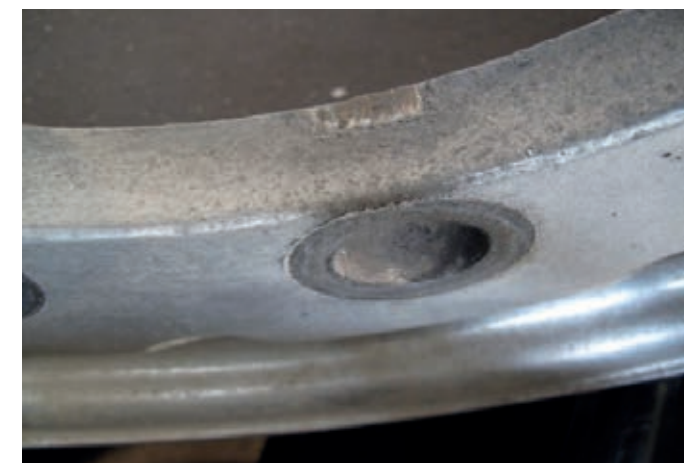
Corrosión galvánica en el área de la válvula y en el interior del orificio
